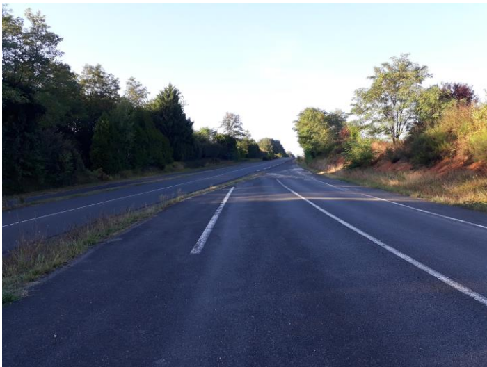
Accès depuis la RD 941 sur ancienne bretelle du giratoire
