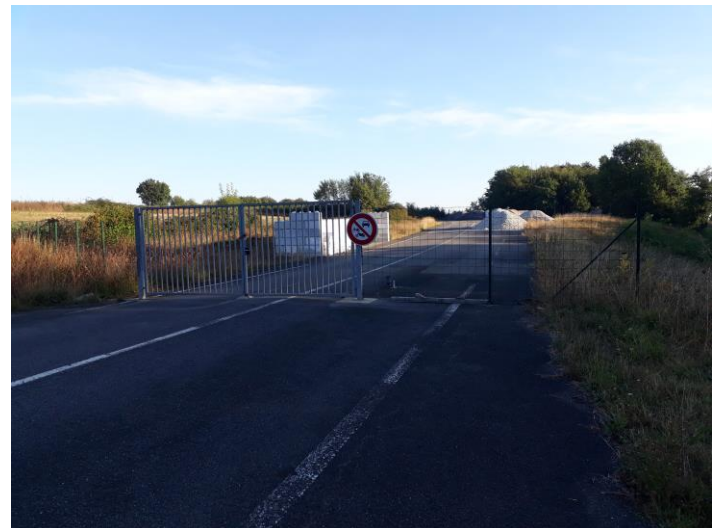
Portail et clôture
